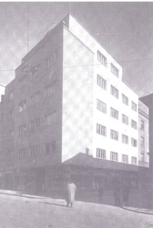
Milovan Kovačević, trgovačka i stambena zgrada Danila Stojasavljevića, Petrinjska 47/ Mrazovićeva 1, 1937./38. Izgled po dovršetku gradnje
