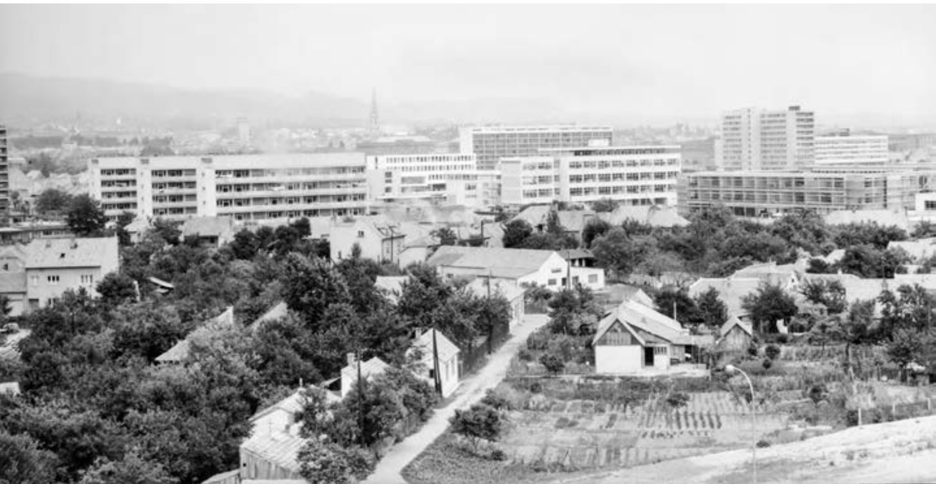
Pogled na Filozofski fakultet, Visoku školu za pogonske inženjere (danas Fakultet strojarstva i brodogradnje) i Radničko narodno sveučilište Moša Pijade (danas Pučko otvoreno učilište) u izgradnji, oko 1960. (IPU, FAB, neg. BB-R-01638, 6 x 6 cm, detalj)
