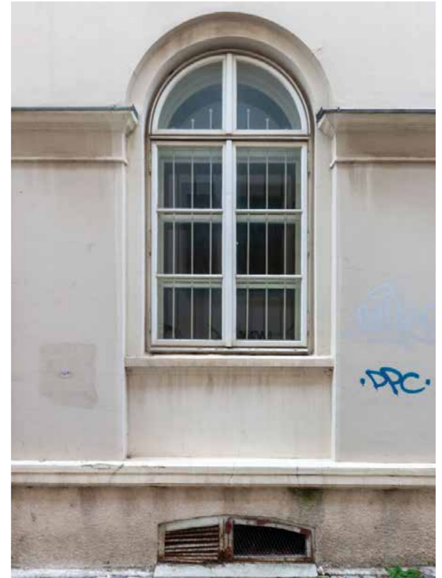
Prozor na sjevernom pročelju
