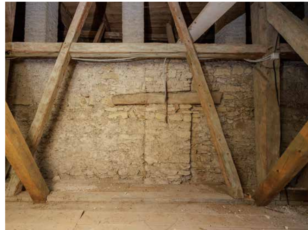
Raščlamba zida glavnog broda pilastrima vidljiva u potkrovlju
