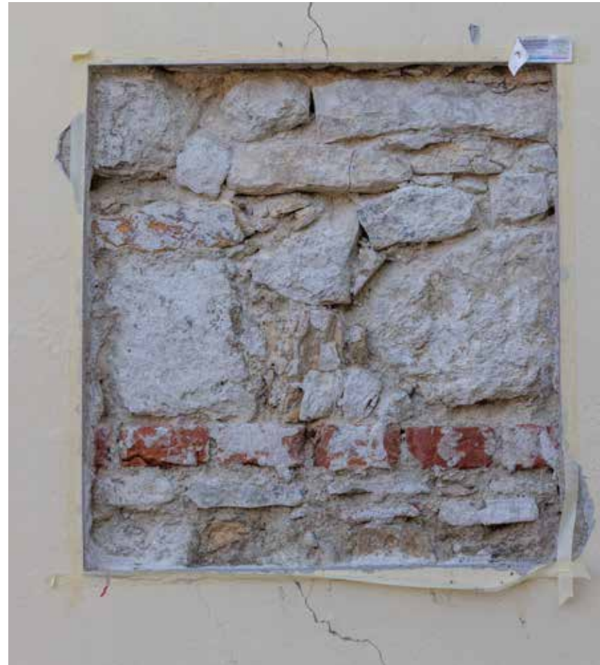
Kamena građa kombinirana s opekom na južnom bočnom brodu crkve
