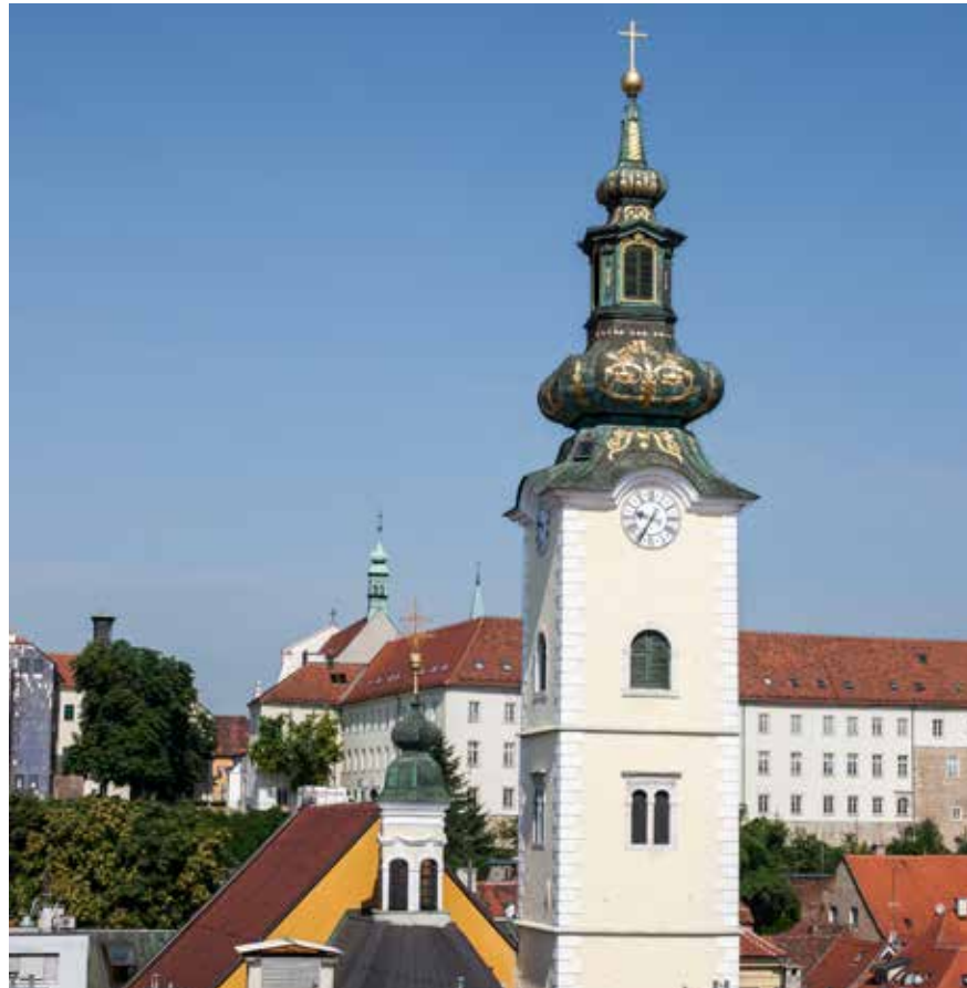
Župna crkva sv. Marije na Dolcu u Zagrebu, pogled na kupolu iz 1760.
