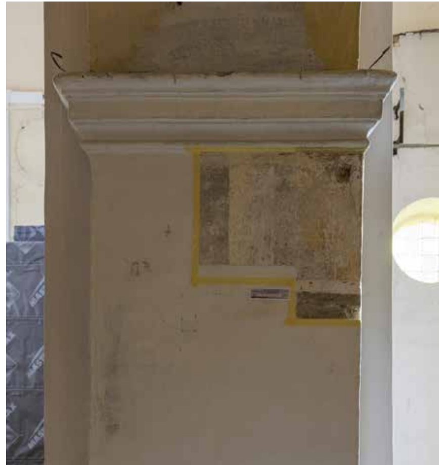
Restauratorska sonda na pilastru stupca između glavnog i južnog broda sa slojevima naliča
