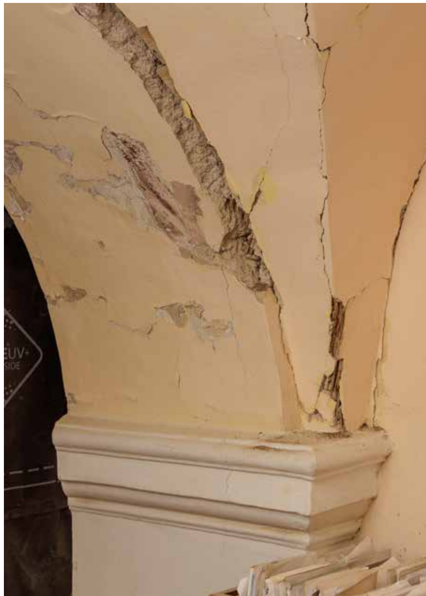
Oštećenja od potresa 2020. u unutrašnjosti crkve
