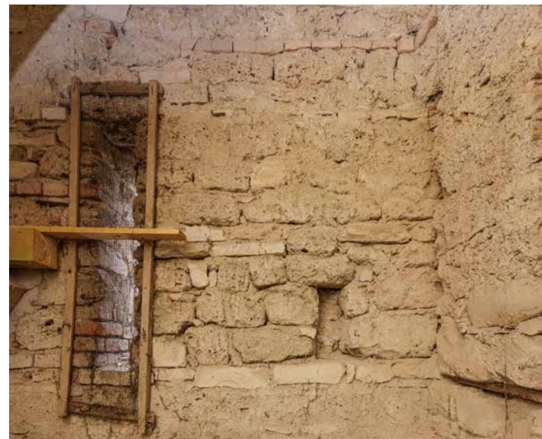
Reška između zida glavnog broda i obnovljenog pročelja
