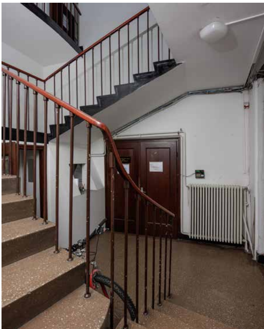
Stubište s jugoistočne strane
