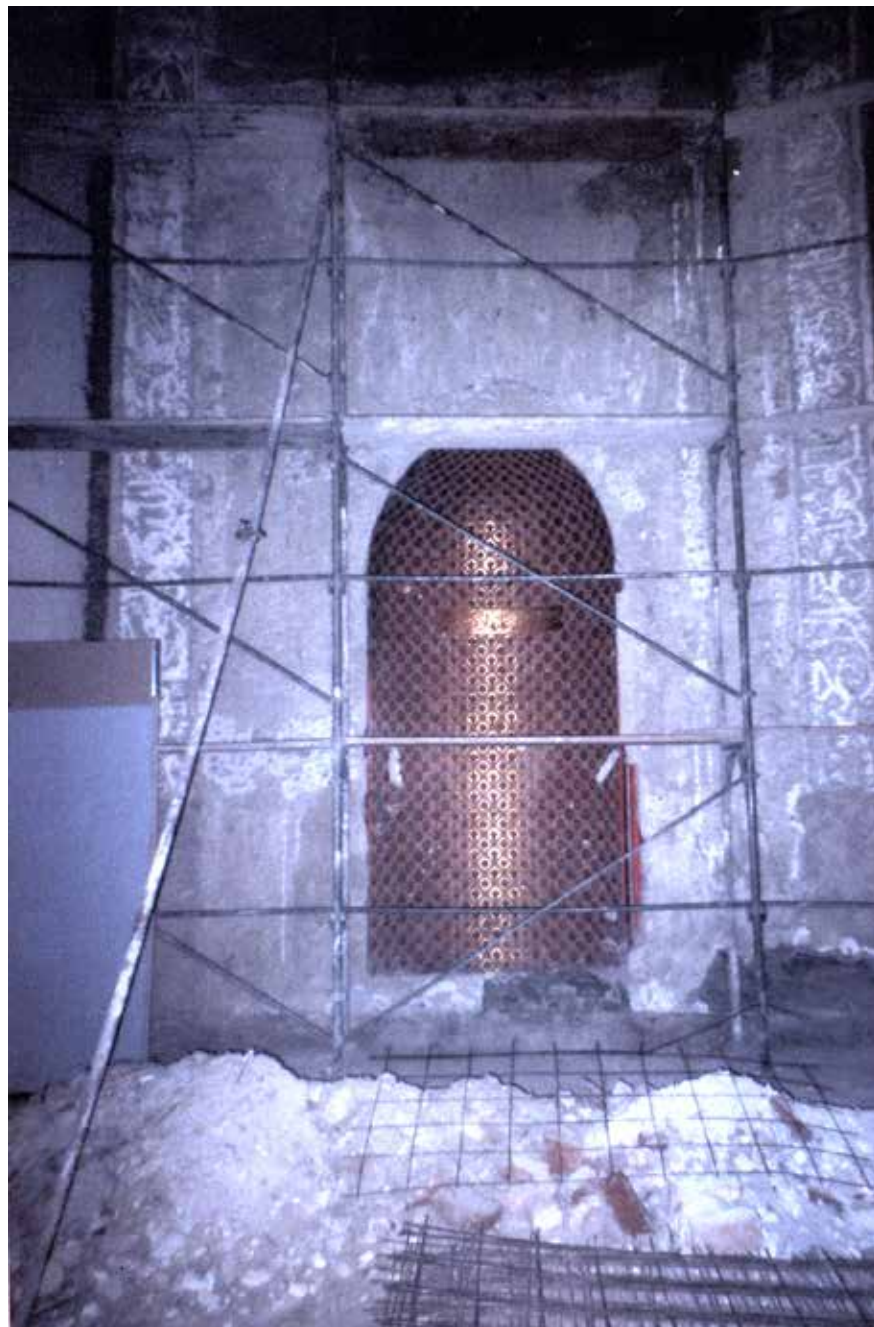
Mihrab prilikom demontaže i uklanjanja, 2003., GZZSKP
