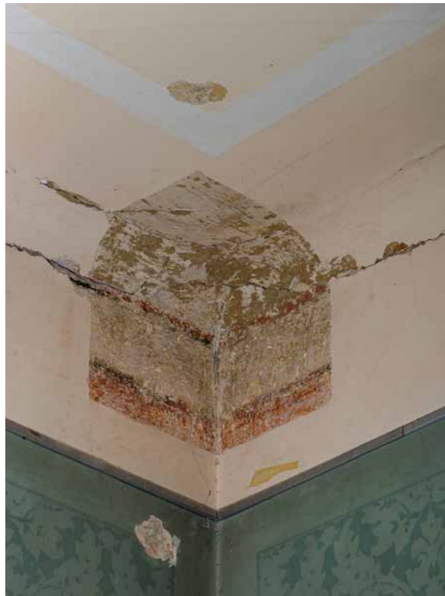
Sonde na zidu i stropu
