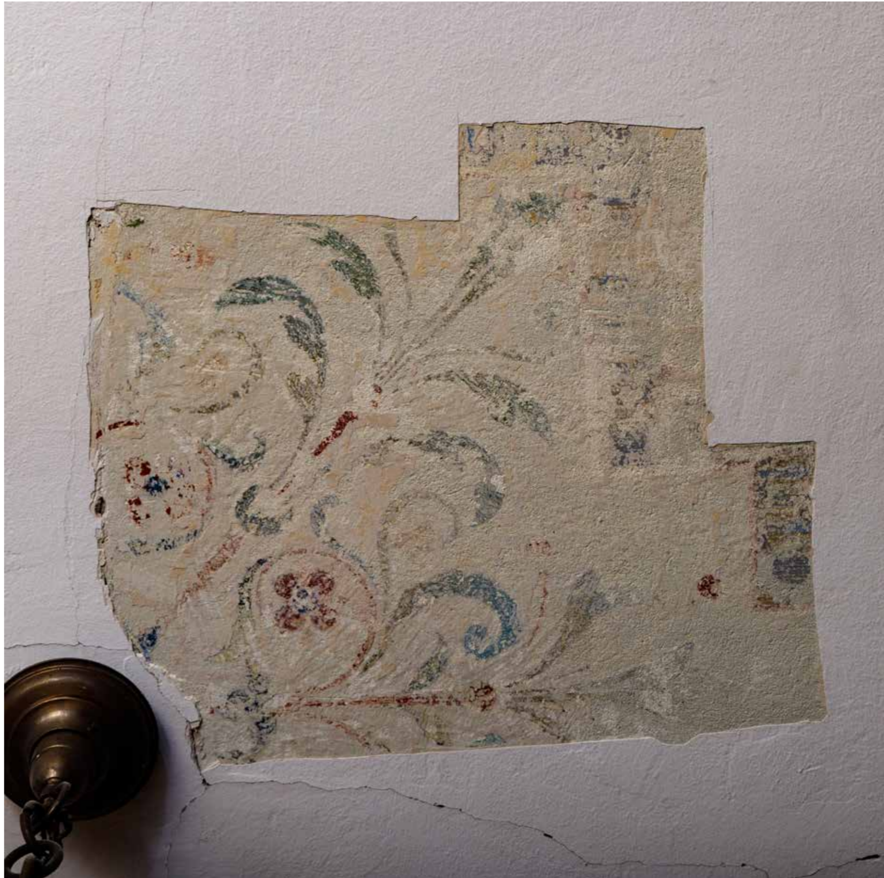
Velika sjednička dvorana, sonde na stropu
