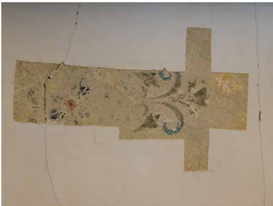
Velika sjednička dvorana, sonde na stropu
