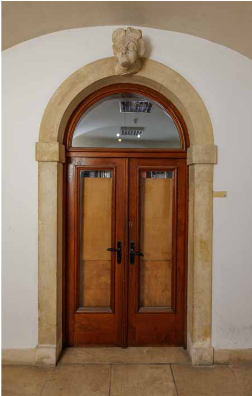
Portal na podestu stubišta u prizemlju
