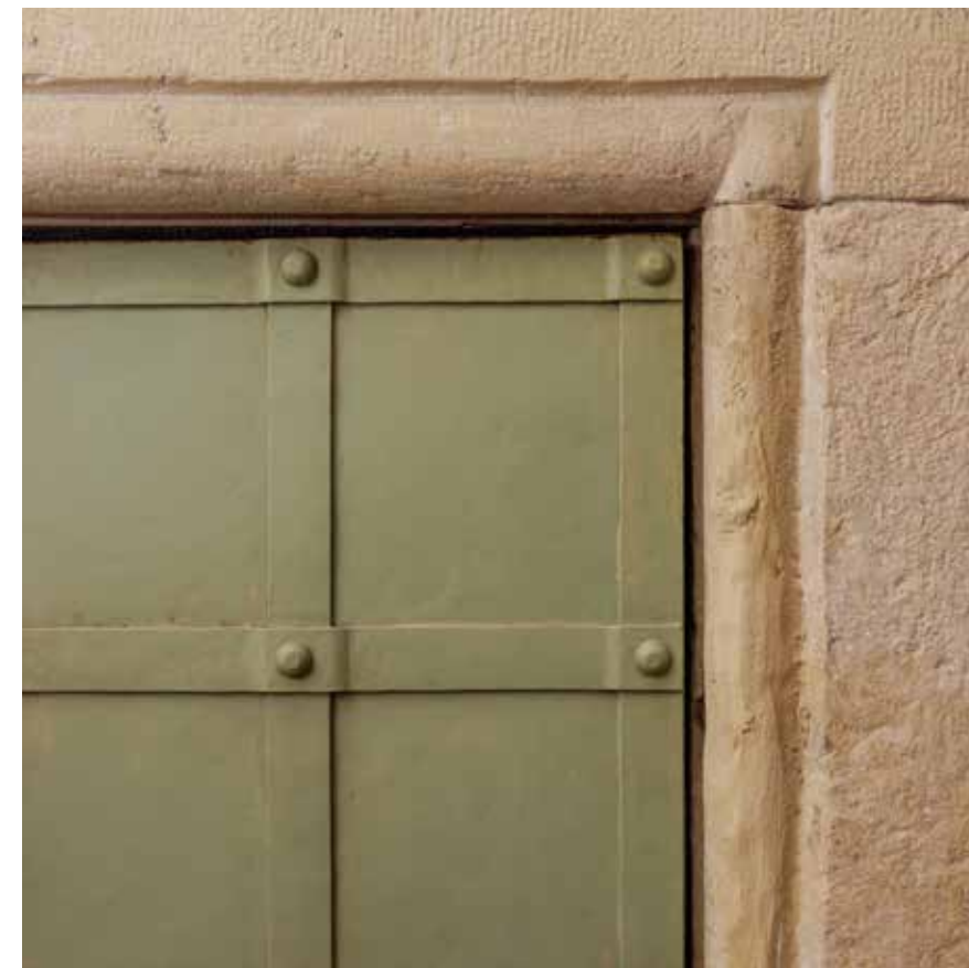
Portal spremišta ispod stuba, detalj
