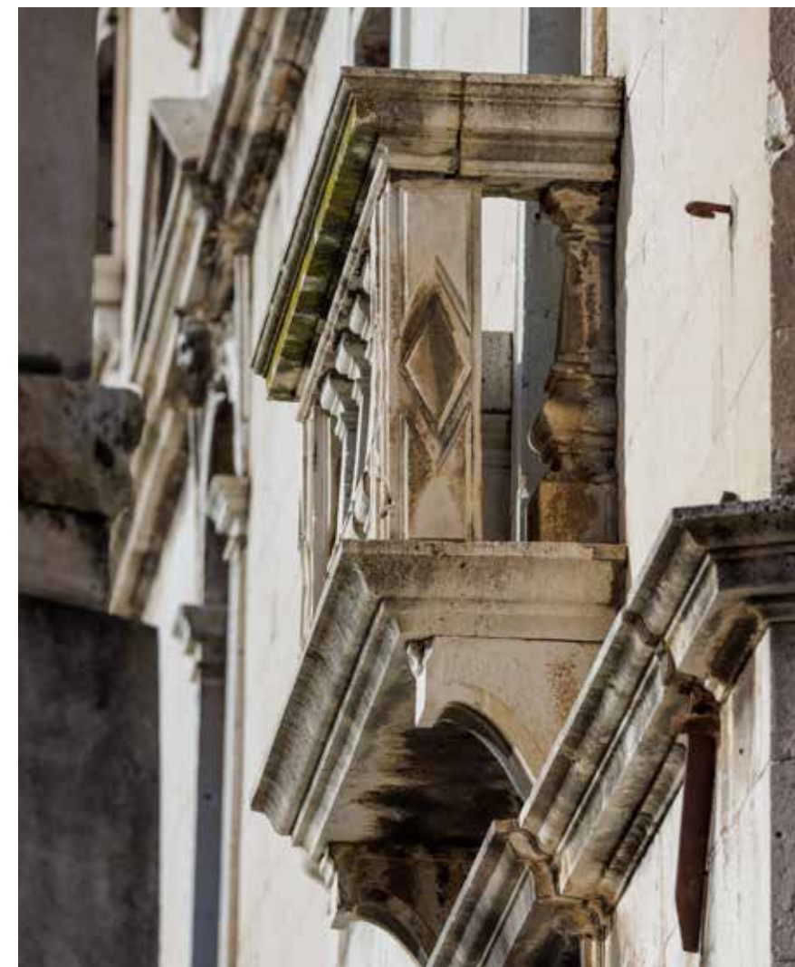
Ograda balkona na drugom katu
