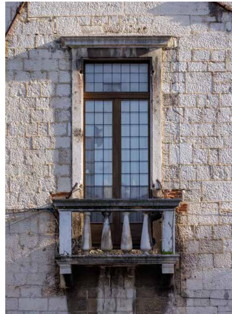
Balkon na prvom katu
