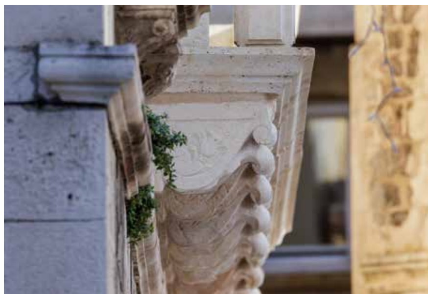
Konzole balkona na prvom katu
