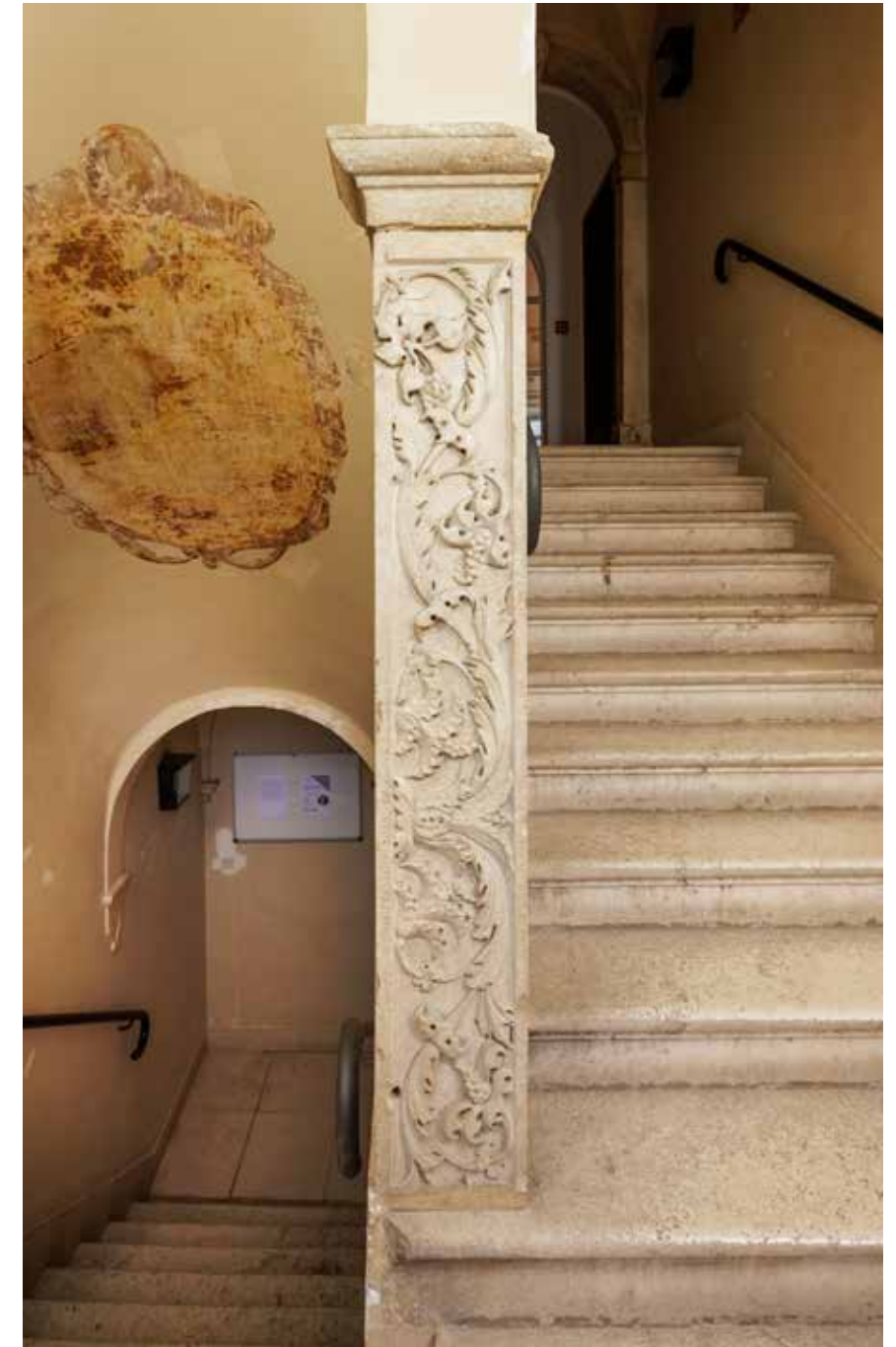
Renesansni pilastar sekundarno ugrađen na podestu između drugog i trećeg kata
