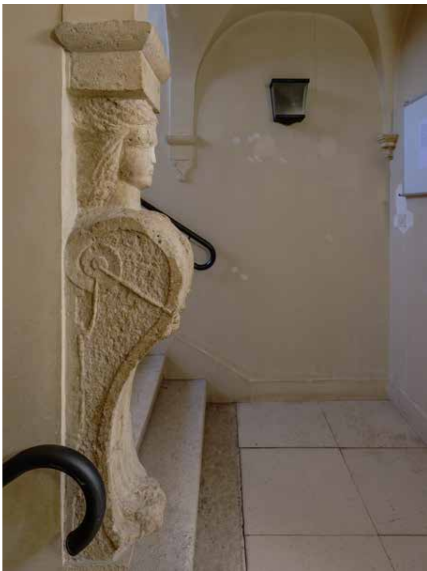
Herme u stubištu, detalji
