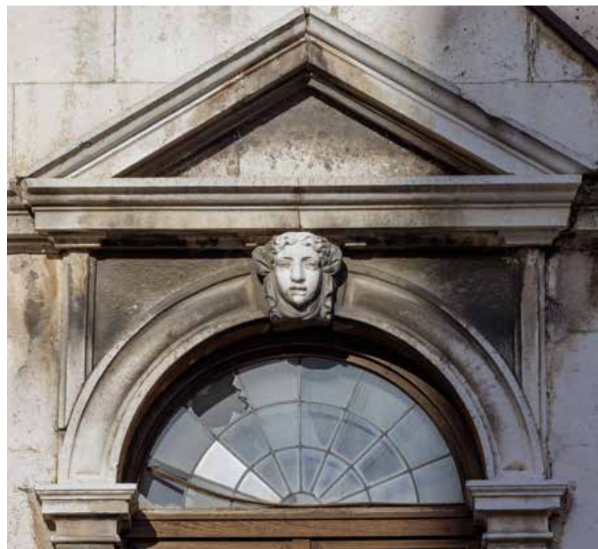
Balkonska vrata na prvom katu, detalj
