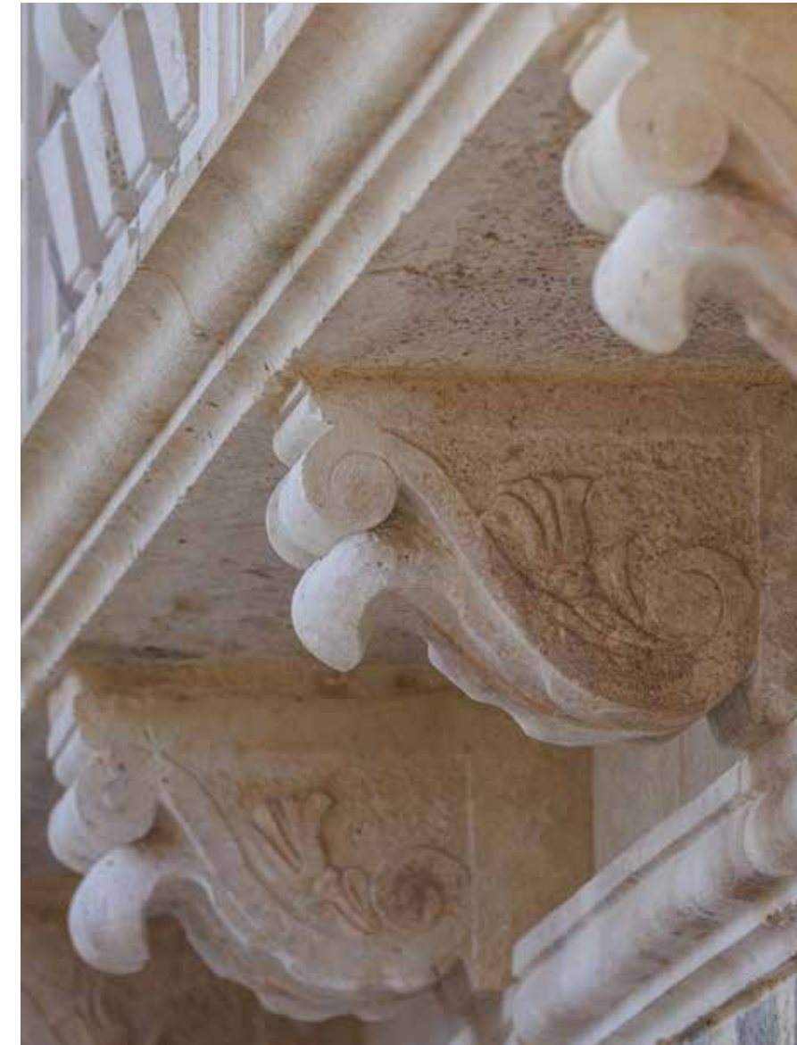
Konzole balkona na južnom pročelju nakon restauracije
