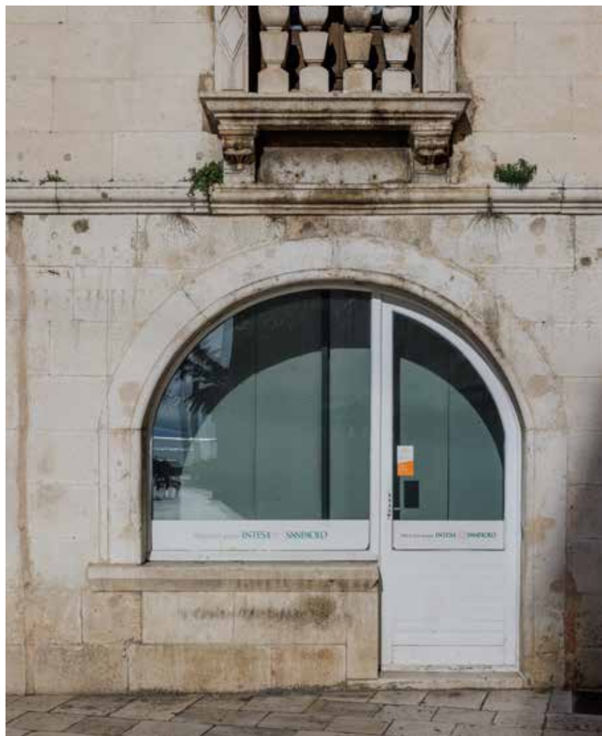
Južno pročelje, dućanski otvor u prizemlju
