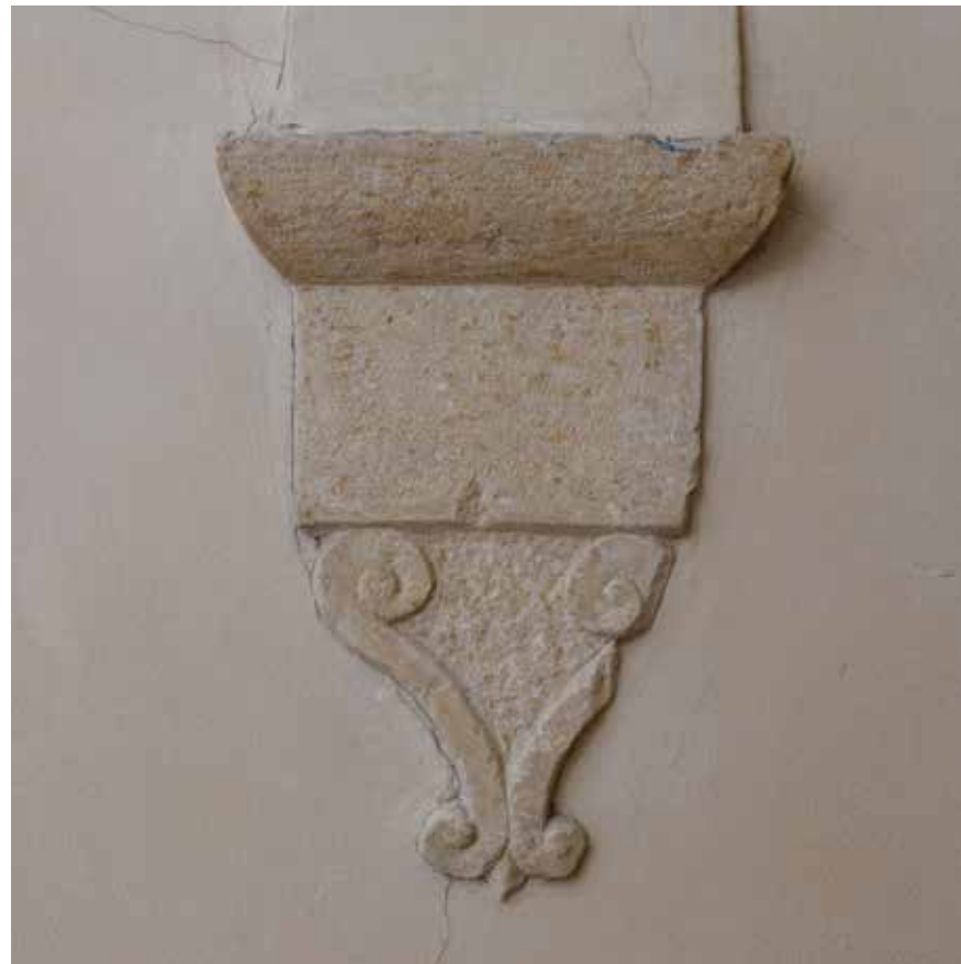
Konzola na podestu na prvom katu
