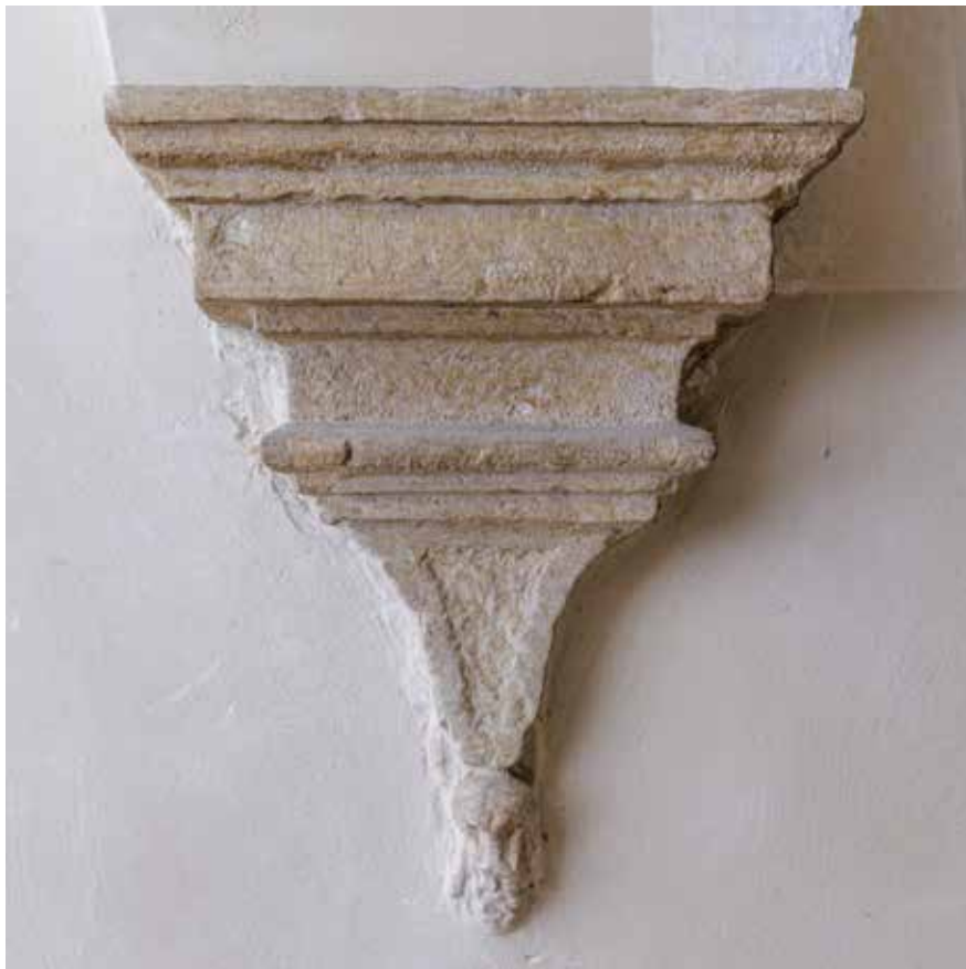
Konzola na podestu u prizemlju
