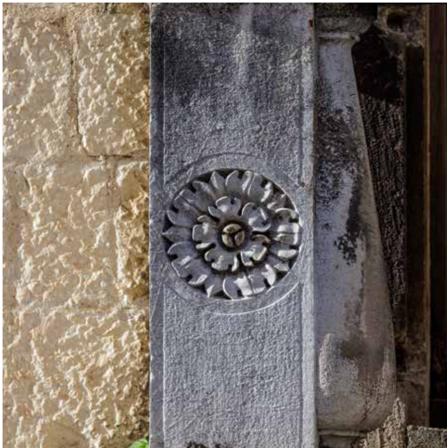
Balkon na prvom katu, detalj
