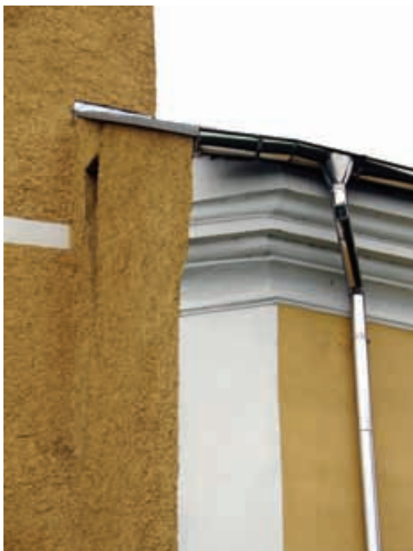
DETALJ VIJENCA NA JUGOZAPADNOM UGLU LAĐE
