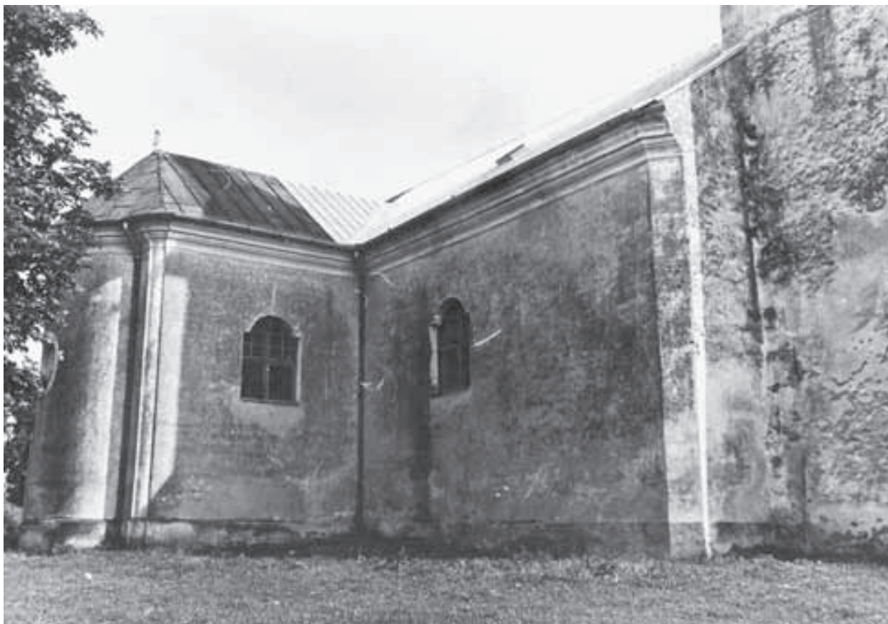
BOČNA KAPELA I SJEVERNO PROČELJE LAĐE
