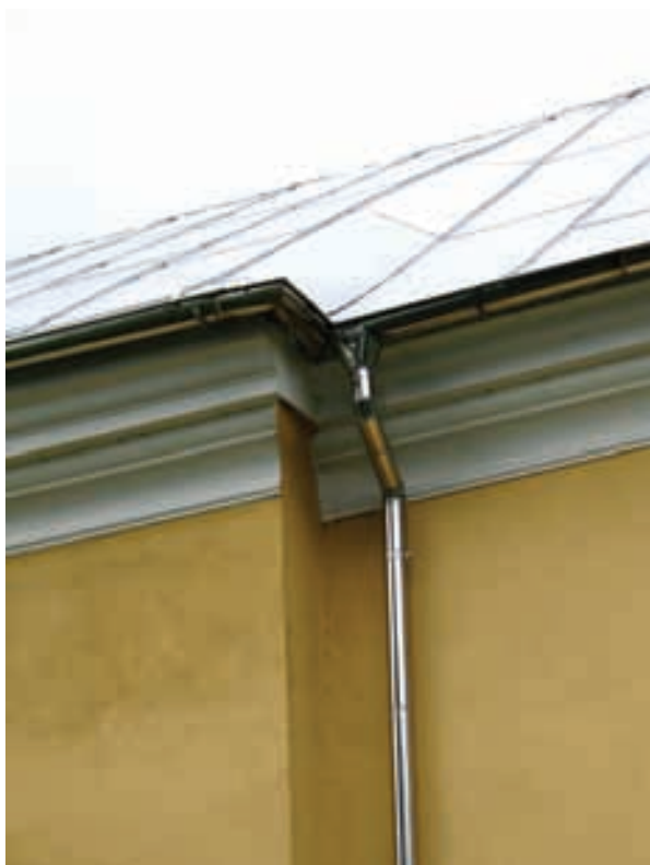
DETALJ VIJENCA NA SPOJU LAĐE I SVETIŠTA
