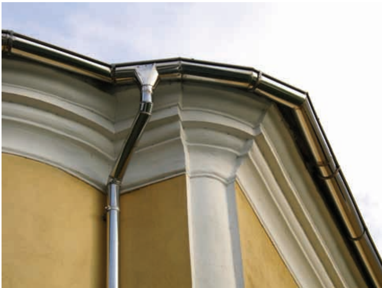
DETALJ VIJENCA - SPOJ ZAoblJENOG I RAVNOG DIJELA BOČNE KAPELE
