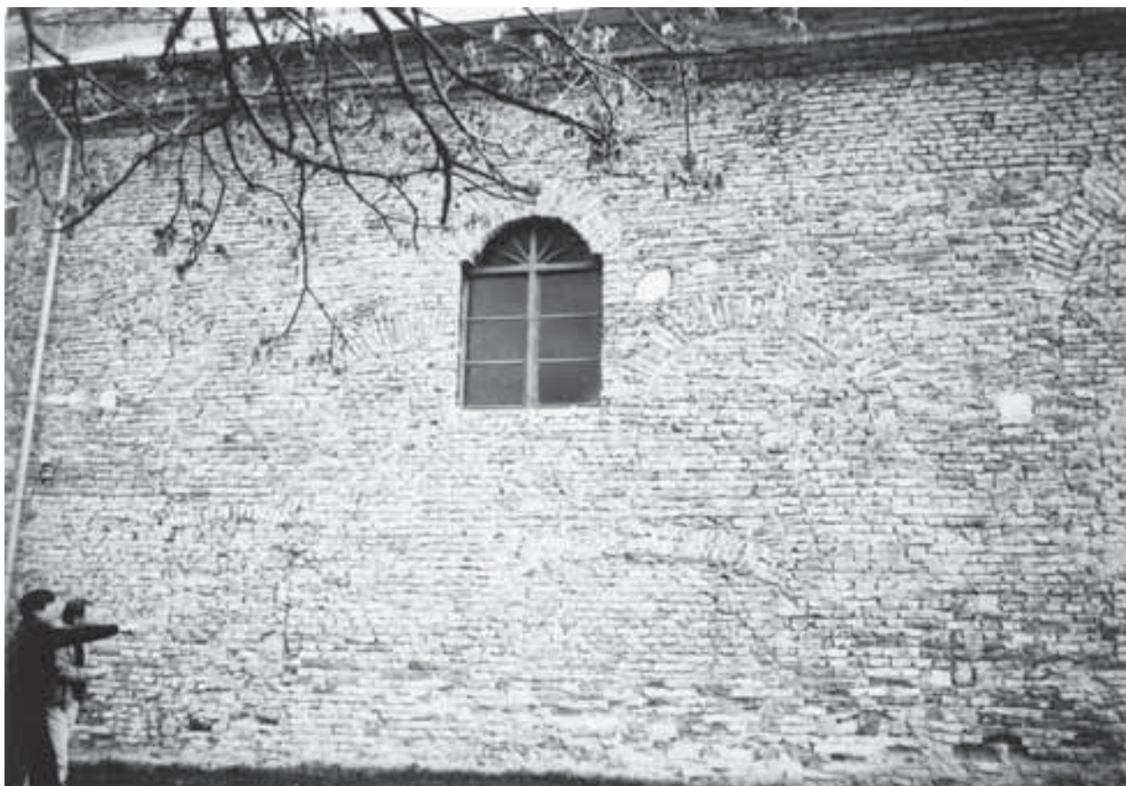
ZAZIDANI RANIJ I OTVORI NA JUŽNOM PROČELJU
