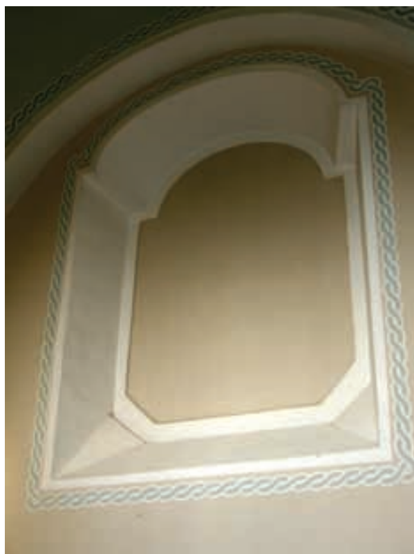
ZAČIDANI PROZOR NA ISTOČNOM ZIDU BOČNE KAPELE
