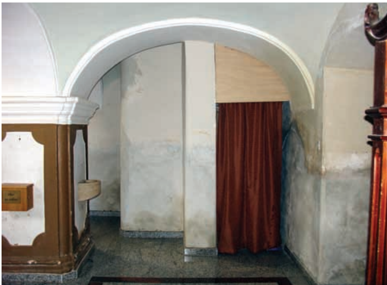
POGLED PREMA STUBIŠTU POD PJEVALIŠTEM
