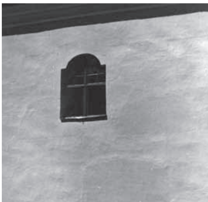
JUŽNO PROČELJE S VIDLJIVIM PREGRADNJAMA
