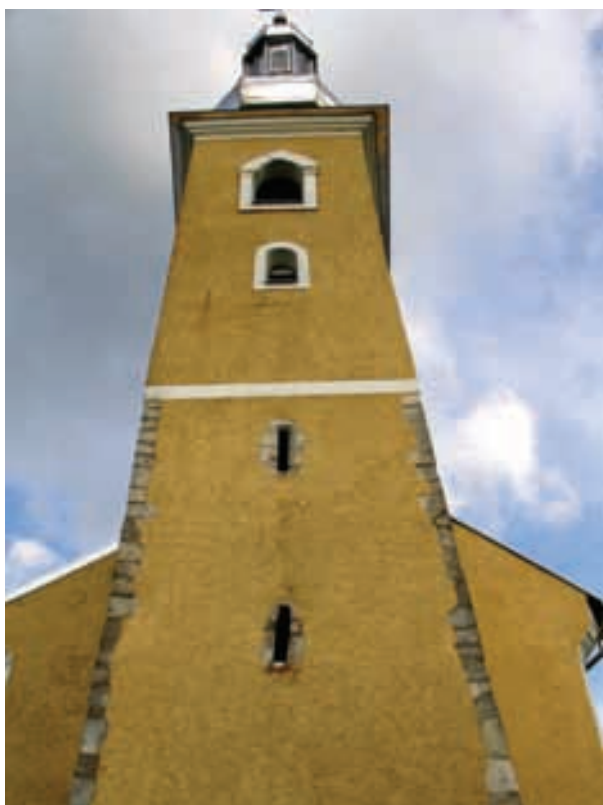
ZAPADNO PROČELJE GORNJEG DIJELA ZVONIKA
