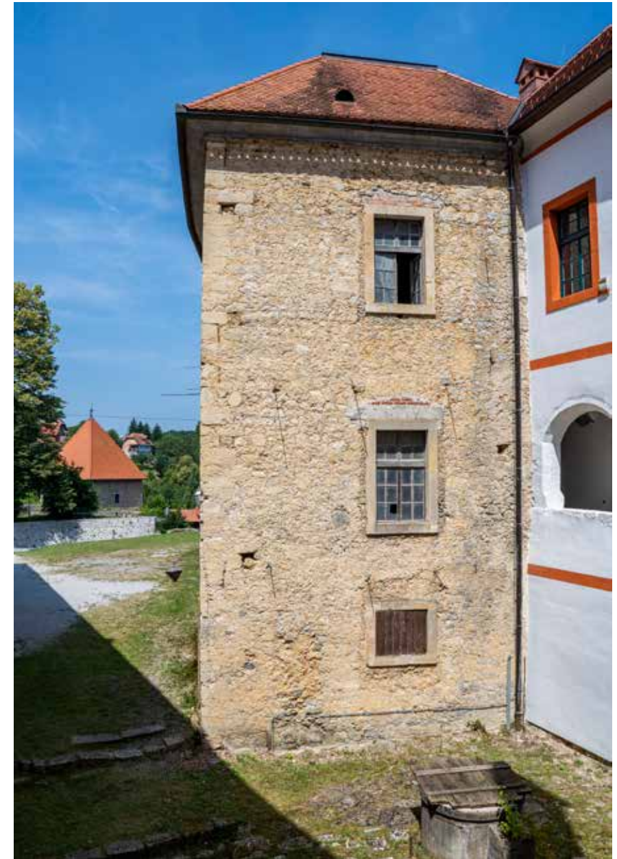
Istočno pročelje stubišta sjevernog krila
