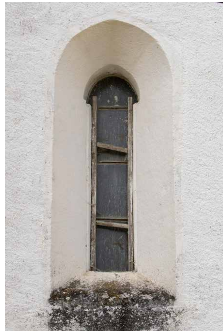
Gotički prozor na sjevernom pročelju
