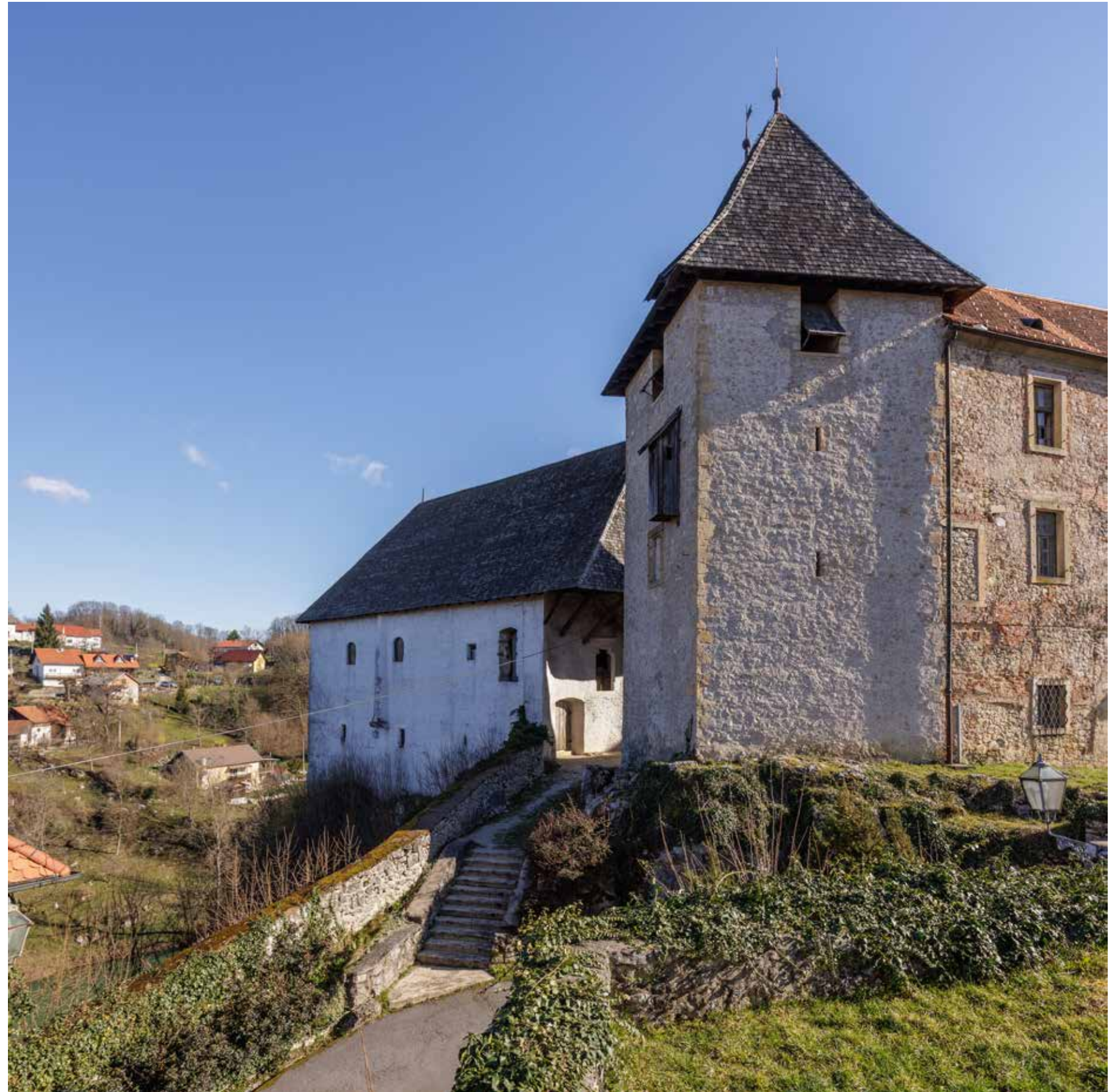
Pogled na južno i zapadno pročelje branič-kule
