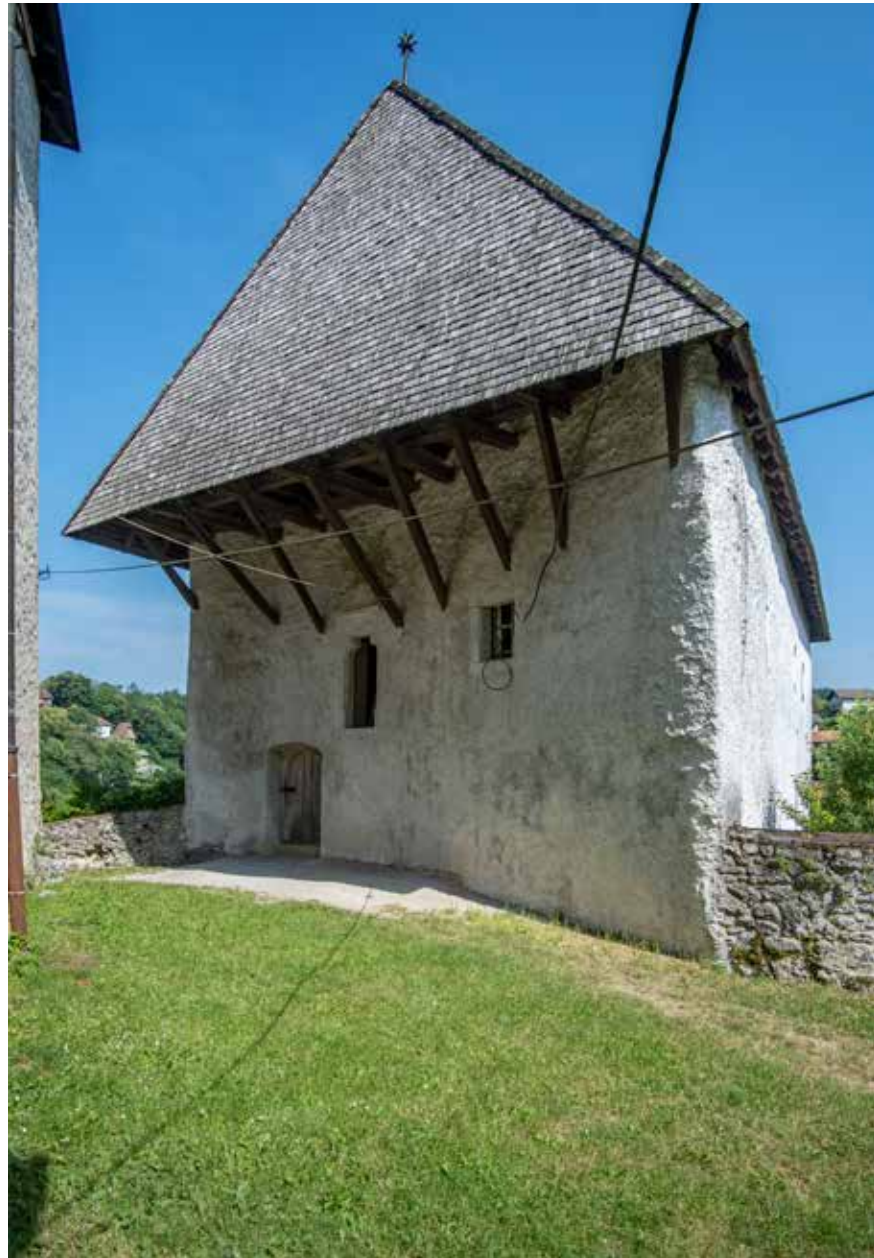
Glavno, južno pročelje Žitnice
