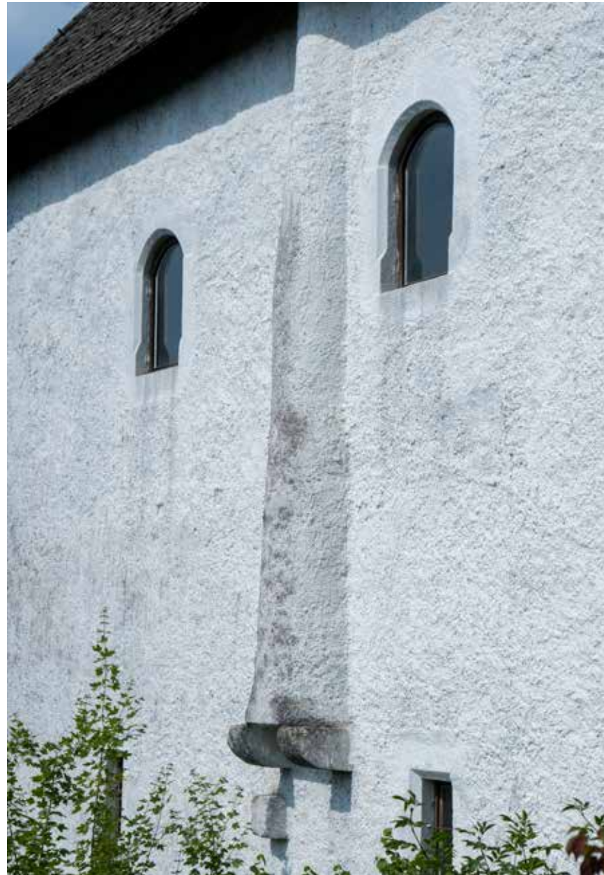
Dimnjak na zapadnom pročelju Žitnice
