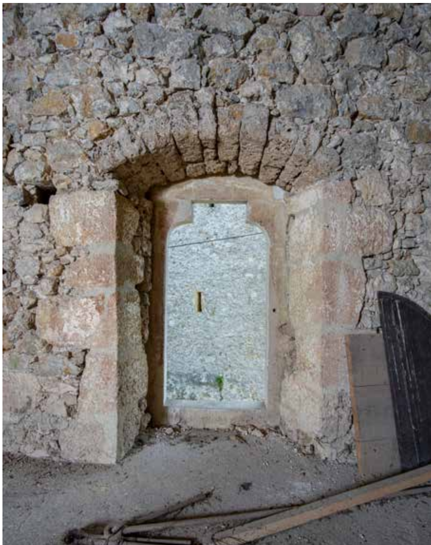
Južni zid predvorja Žitnice s portalom Nikole Zrinskog Niša vrata Nikole Zrinskog u južnom zidu predvorja
