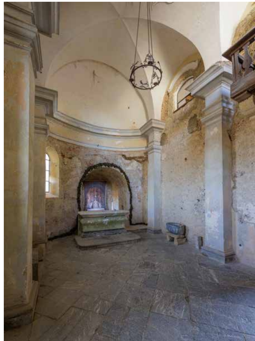
Pogled na južni zid
