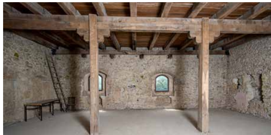
Pogled na zapadni zid predvorja na prvom katu Žitnice Dvorana na katu Pogled na zapadni zid dvorane na prvom katu
