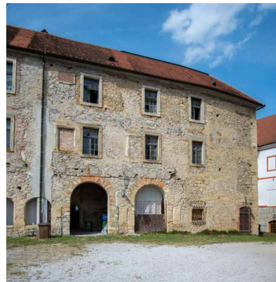
Južno pročelje sjevernog krila uz branič-kulu
