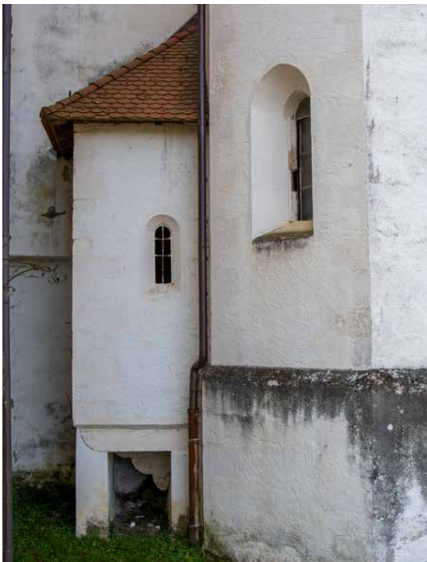
Apsida i sjeveroistočni zid kapele
