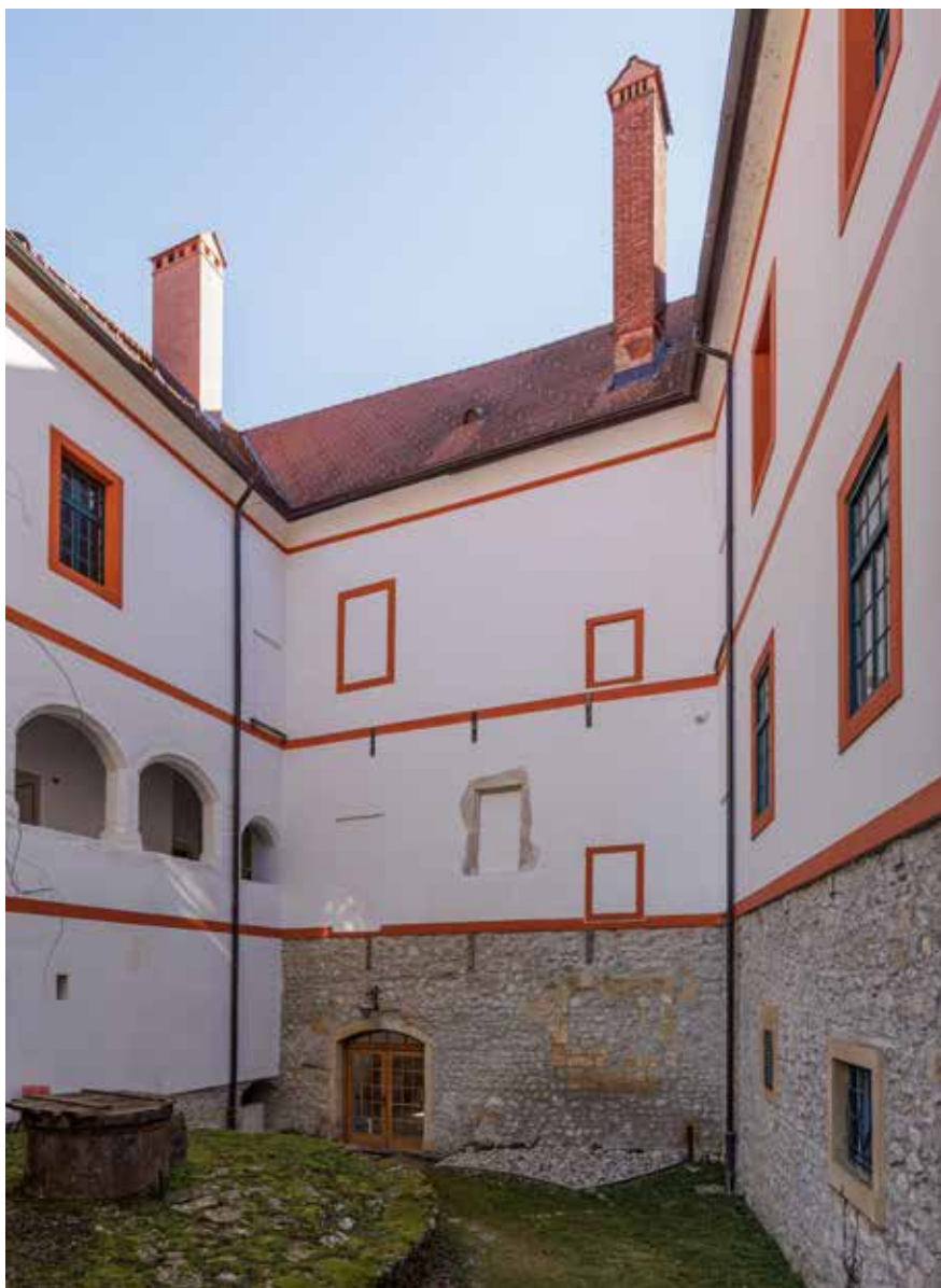
Zapadno pročelje istočnog krila
