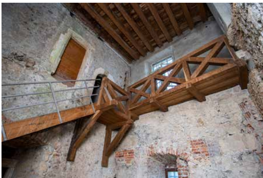
Dvokrako željezo-drveno stubište uz istočni zid branič-kule Pogled na ulazno, istočno pročelje
