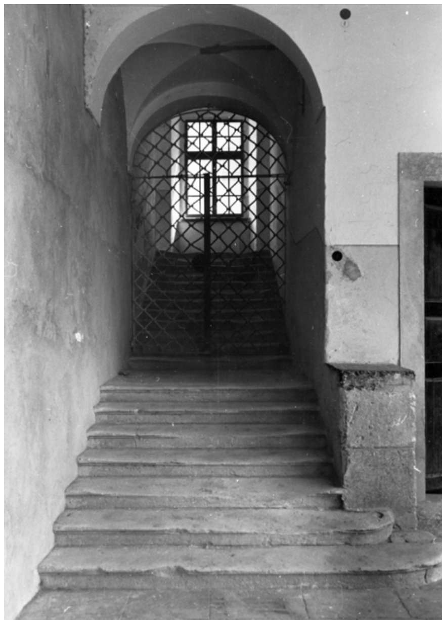
Barokno stubište sjevernog krila u prizemlju (MKM)
