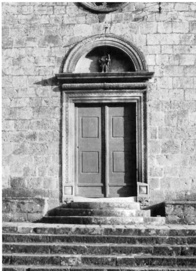
Crkvena glavna vrata na sjevernoj strani The main door of the church on the north side
