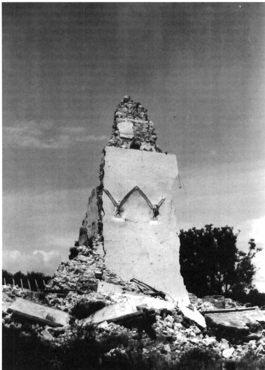
Voćin, Župna crkva sv. Marije, ruševine crkve poslije razaranja 1991. (foto: D. Stepinac) Voćin, St. Mary, photograph of the church taken after the attack in 1991 (photo: D. Stepinac)
