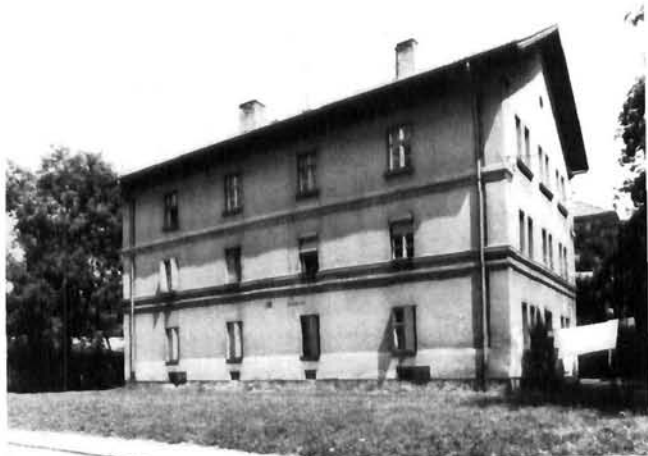
Radnička kuća u Strojarničkom naselju (foto: K. Tadić) Working-class housing in Strojarnička Street (photo: K. Tadić)
