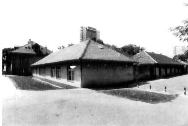
Pogled na južno naselje na Selskoj cesti (foto: K. Tadić) View of the southern housing estate on Selska Road, 1934 (photo: K. Tadić)
