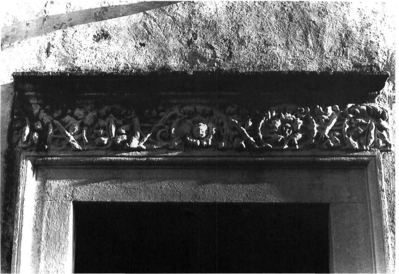
Arhitravni vijenac klasičnog ukrasa na pročelju Gospe od Ružarija u Preku (foto: M. Stagličić) Architrave-Cornice, with classical ornamentation on facade of Our Lady of the Rosary in Preko (photo: M. Stagličić)
