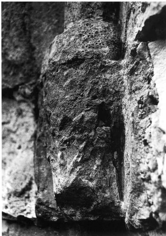
Oštećeni lijevi kapitel vanjskog stupića i baza vanjskog polukružnog oktogonalnog štapa s tragovima svrdla (foto: M. Drmić)
