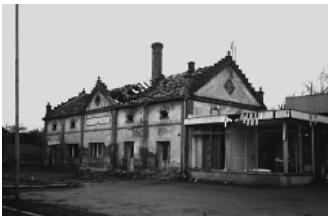
25. Parna »Pekara« u Pakracu s nasilno prigradenom metalnom konstrukcijom autobusne stanice »Croatiatransa«, sve razrušeno tijekom srpske agresije. /III/1992. g./
