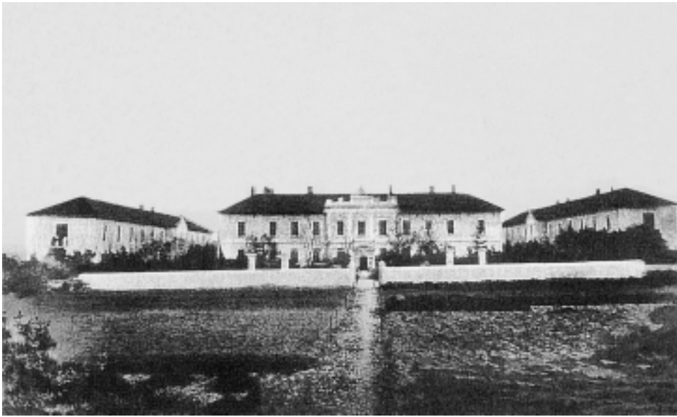
Bolnica u Arbanasima u Zadru (obj. u: »Sestre milosrdnice«, Zagreb 1998.) Hospital in Arbanasi in Zadar (published in »Sestre milosrdnice«, Zagreb, 1998)
