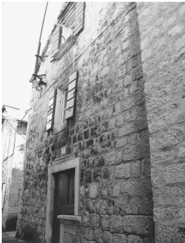
Trogir, kuća Macanović, Matice hrvatske 35, pogled na sjeverno pročelje Trogir, Macanović house, Matice hrvatske 35, view of north façade
