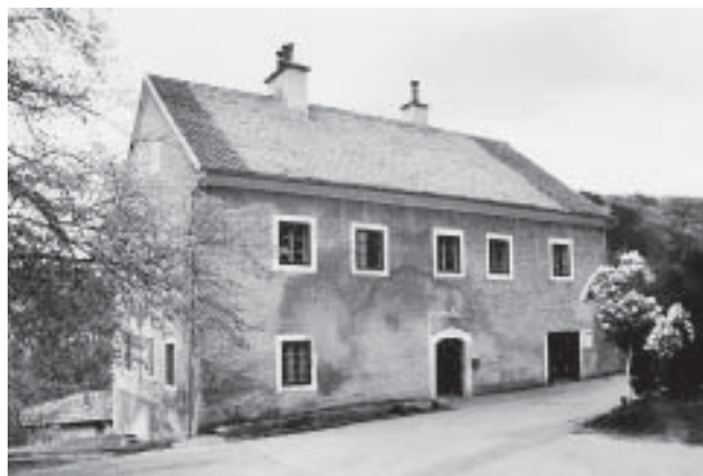
Lobar, župna kurija, istočno pročelje (foto: M. Drmić) Lobar, parish house, east façade
