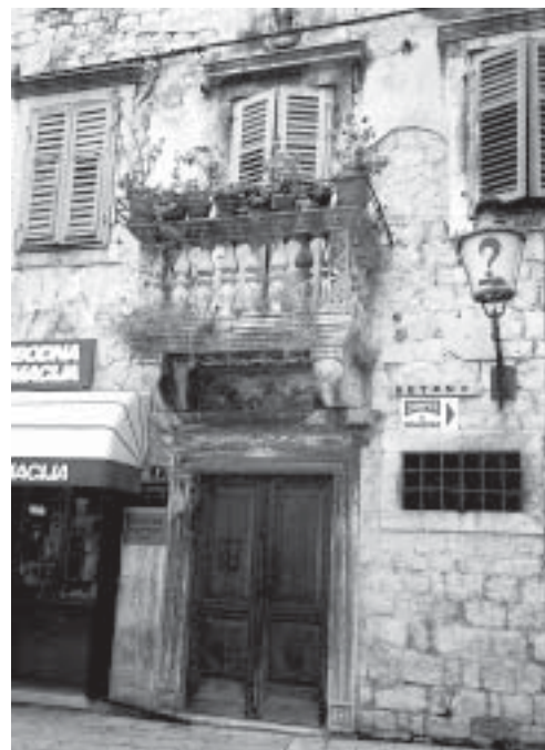
Kuća De Caris, Cosmijeva 1, pročelje, portal i balkon prvog kata (foto: V. Jakaša) De Caris house, Cosmijeva 1, façade, portal and second floor balcony
