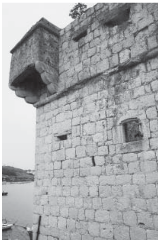
Perastijeva kula, tragovi nekadašnjega kruništa na zapadnom pročelju i ugaona stražarnica (foto: K. Horvat-Levaj)
