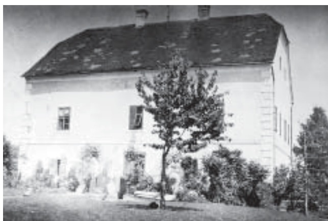
Belec, župna kurija, zapadno pročelje (foto: Gj. Szabo, Uprava za zaštitu kulturne baštine, Zagreb) Belec, parish house, west façade
