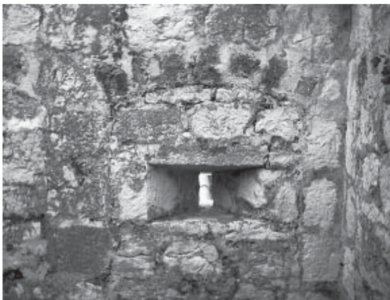
Perastijeva kula, unutrašnji zid sa zazidanim otvorima nekadašnjega kruništa (foto: M. Renić)
