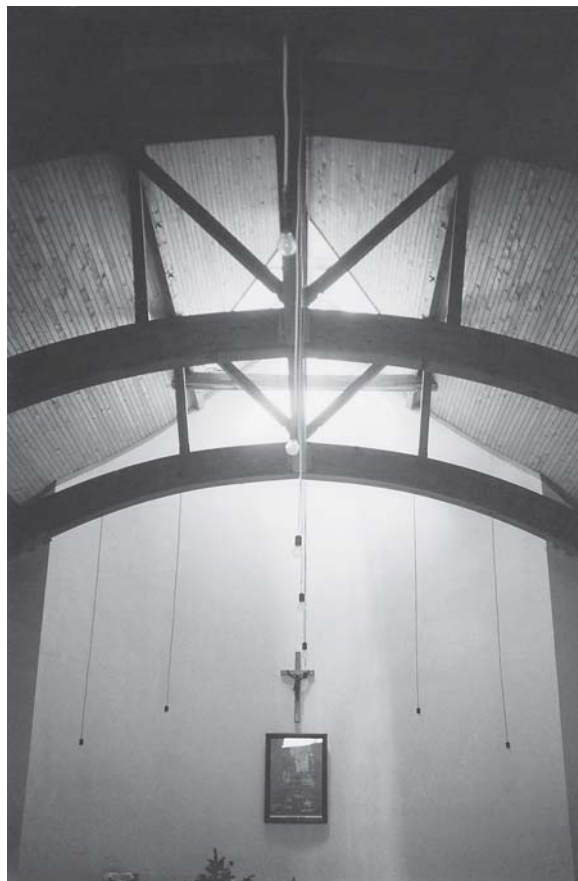
Z. Hanžek, crkva u Hrgovima Donjim, detalj krovne konstrukcije Z. Hanžek, church in Hrgovi Donji, roof construction detail
