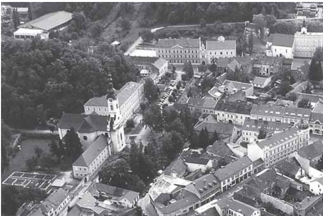
Požega, kompleks Sv. Terezije, pogled iz zraka (iz: Kulturna baština Požege i Požeštine )
