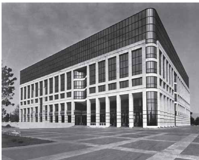
Zagreb, INA trgovina, Av. V. Holjevca/Av. Dubrovnik (V. Neidhardt, 1988.)
