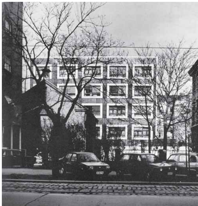
Zagreb, zgrada PTT Gradski telefon, Palmotićeve ul. (M. Šosterić, 1987.) Zagreb, City Telephone Company Office, Palmotićeve ul. (M. Šosterić, 1987)
