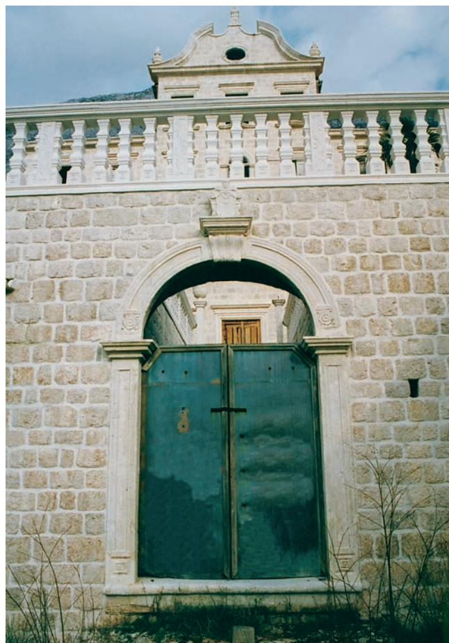
Boka kotorska (Dobrota), palača Tripković, portal terase (foto: K. Horvat-Levaj) Boka Kotorska (Dobrota), Tripković palace, portal terrace
