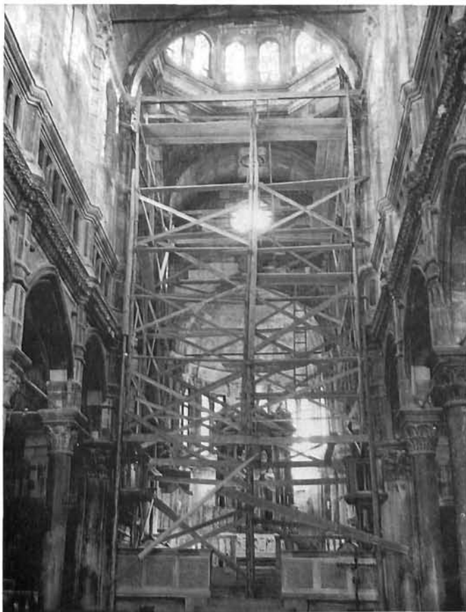
12. Šibenik, katedrala, skela pod kupolom pri radovima na popravku spona, 1963.
