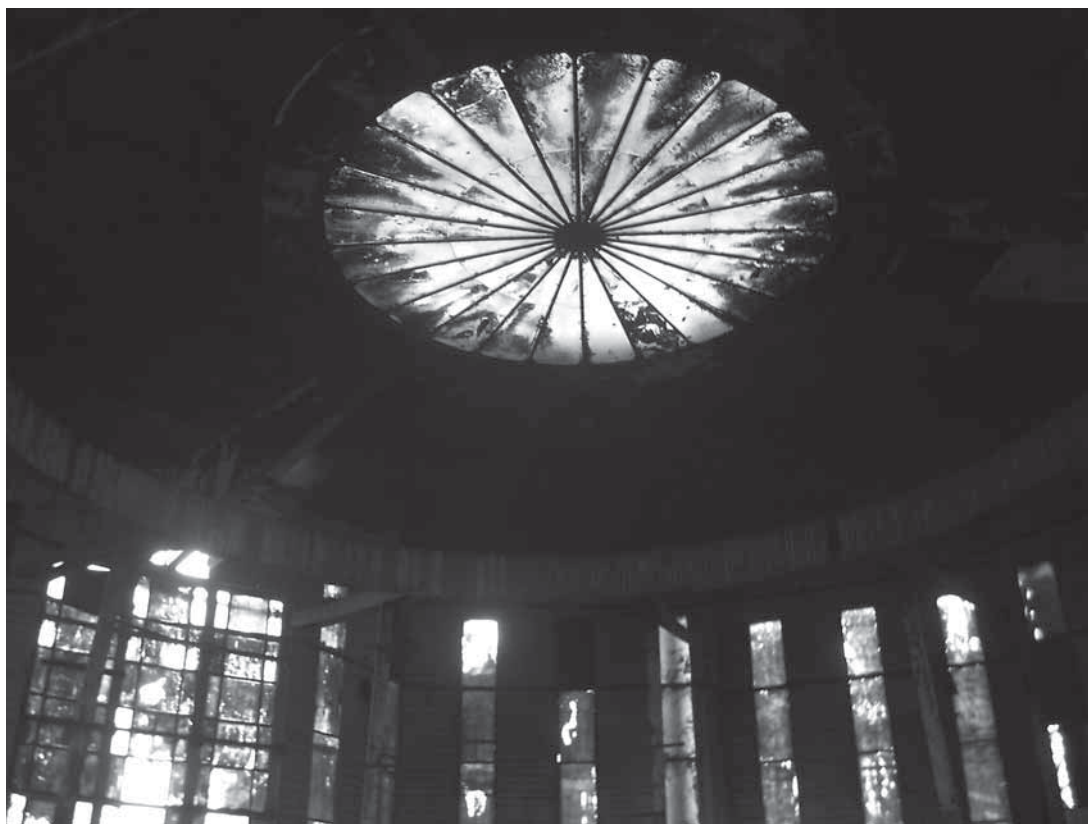
Detalj lanterne (foto: D. Radović Mahečić, 2005.) Detail of the lantern
