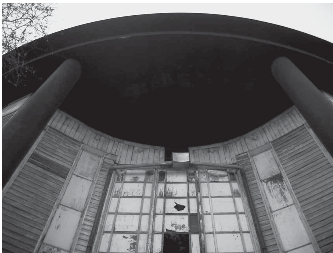
Detalj ulaza (foto: D. Radović Mahečić, 2005.) Detail of the entrance
