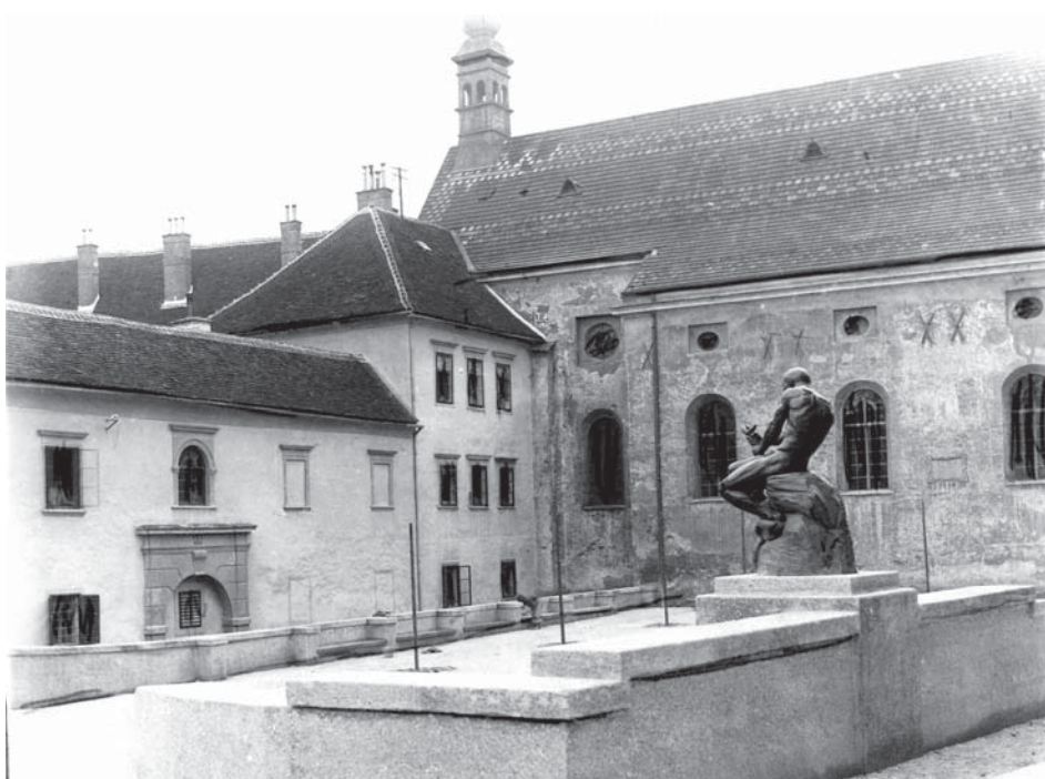
Crkva sv. Katarine u Zagrebu, nekadašnje krovšte snimljeno 1912. godine s pokrovom od raznobojnoga glaziranog crijepa, izvedenim prema projektu Hermana Bolléa (Fototeka Muzeja grada Zagreba)
