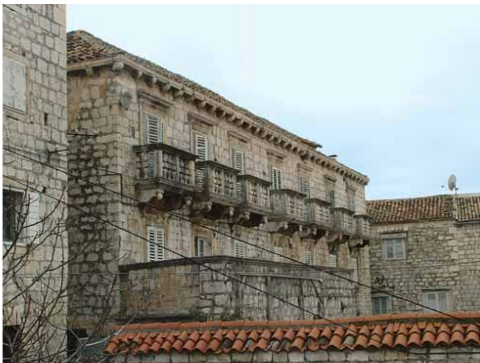
Pogled na sjeverno pročelje palače Radošević
