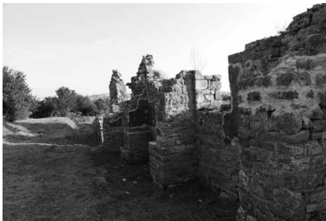
4 Salona, "Velike terme" – kontrafori na istočnome zidu (foto: T. Turković – N. Maraković)
