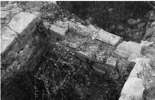
10a, b, c Salona, "Velike terme" – parapetni zidovi bazena; 10a Parapetni zid polukružnog bazena u kaldariju velikoga kupališnog trakta (C, Al); 10b Parapetni zidovi pravokutnih bazena u kaldariju velikoga kupališnog trakta (C, Al); 10c Parapetni zidovi pravokutnih bazena u kaldariju maloga kupališnog trakta (c, Al) (foto: T. Turković – N. Maraković)
