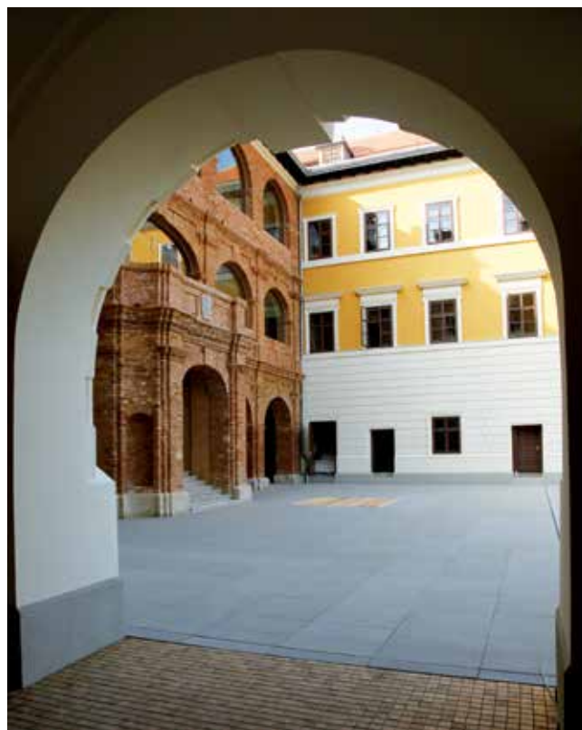
5 Schloss Ilok, Arkadengang der zur Donau offenen Eingangsseite. (Foto: Remmers Baustofftechnik GmbH)
