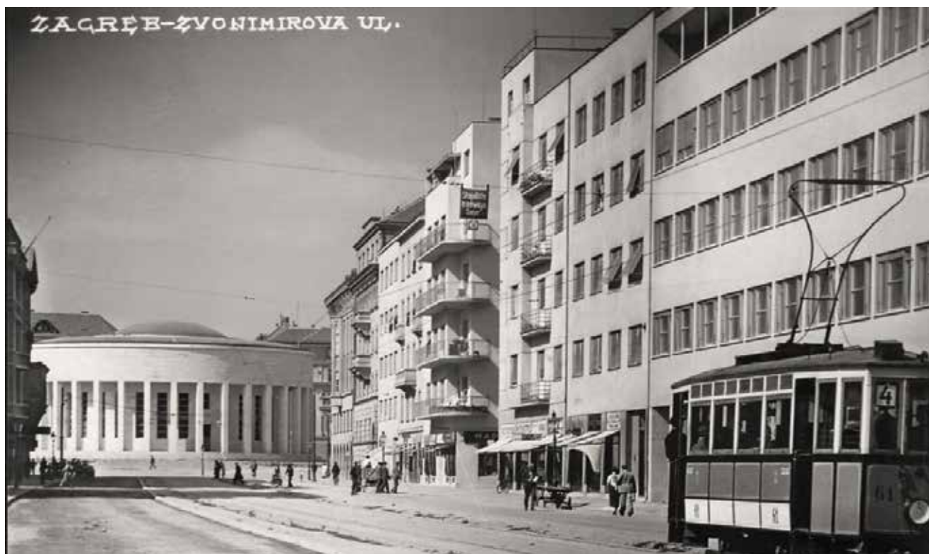
28. Zvonimirova ulica s novom uglovnicom uz Bauerovu Bogdana Petrovića i Javnu burzu rada Vladimira Šterka, oko 1937.
