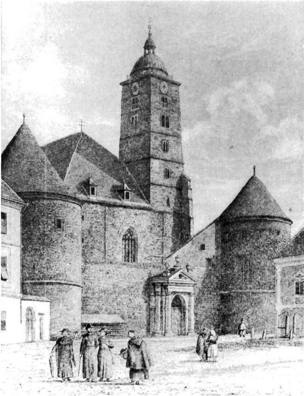
Zagreb, stolna crkva prije potresa
