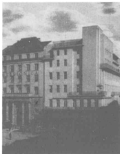
Peter Behrens: Pregradnja kuće Stern (ex "Elsa-fluid") u Jurišićevoj ulici, 1927.-28. Izgled po dovršetku gradnje
