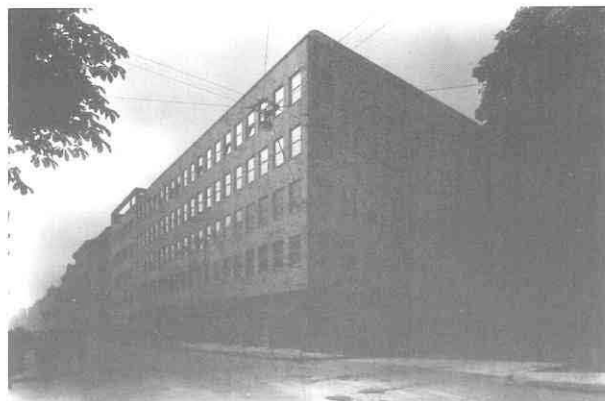
Juraj Denzler: Zgrada Gradskih komunalnih poduzeća u Gundulićevoj ulici, 1932.-34. Prvobitni izgled, fotografija: Tošo Dabac
